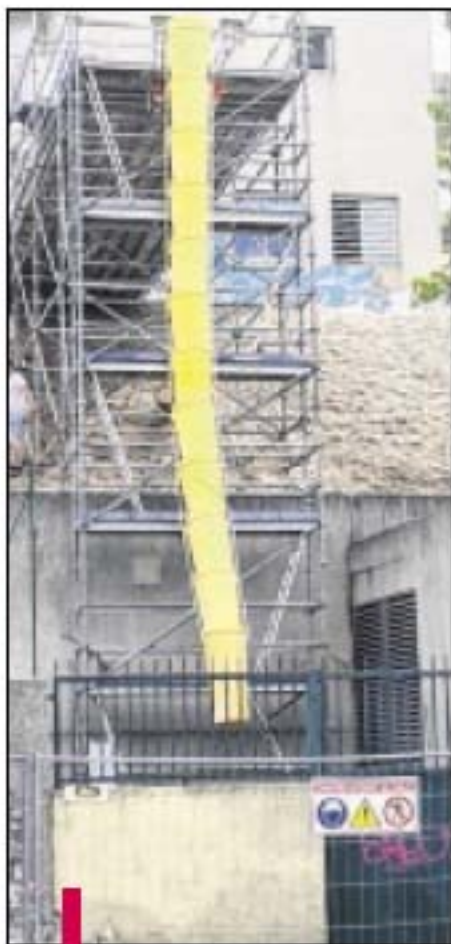
Durant les travaux, cette goulotte jaune transporte les gravats. / PHOTO LDA
